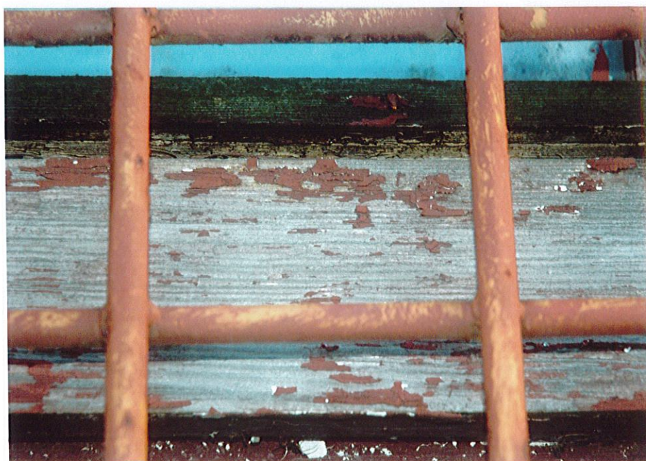
Zbliżenie fragmentu okna. Brak oryginalnych wymalowań.
