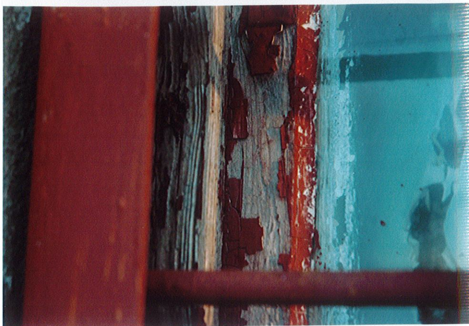
Zbliżenie fragmentu okna. Brak oryginalnych wymalowań.
