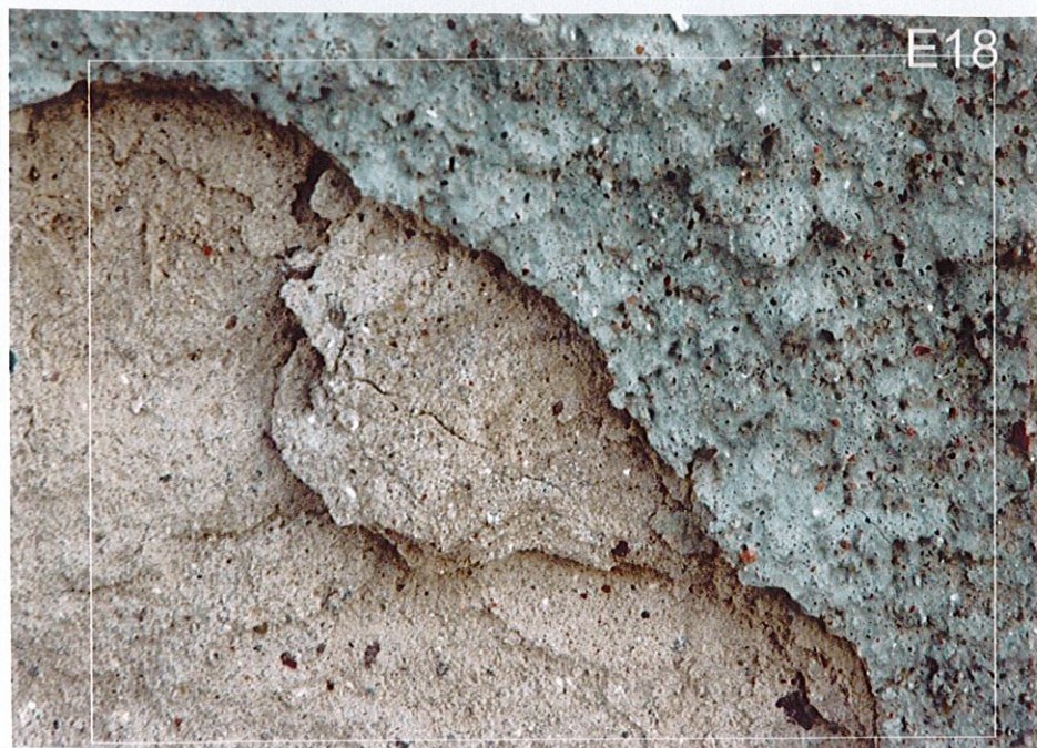
Zbliżenie odkrywki E18. Brak oryginalnych wymalowań tynków.
