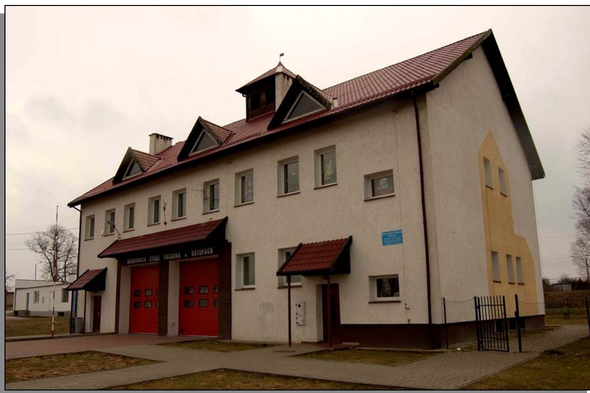
Fot. Remiza straży przeciwpożarowej
