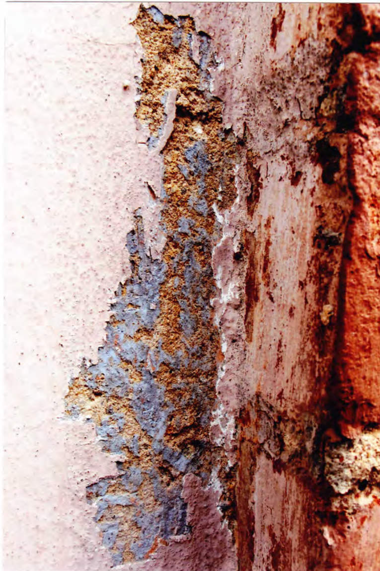
Fot. 13. Odkrywka nr 5 – na tynku pod wtórnymi warstwami widoczne relikty warstwy w kolorze jasnougrowym
