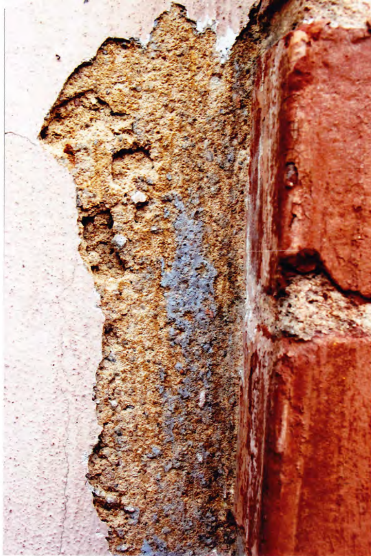
Fot. 7. Odkrywka nr 2 przy oknie na parterze w osi skrajnej, lewej
