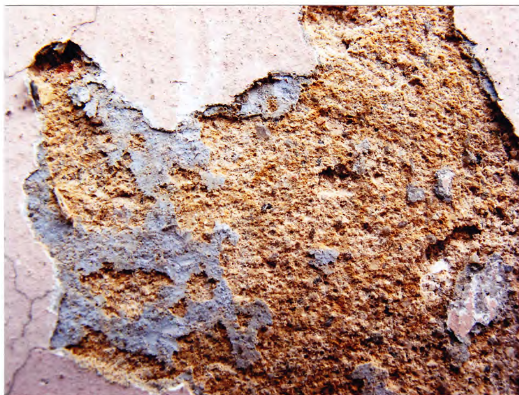
Fot. 12. Fragment odkrywki nr 4 – widoczne jasnougrowe zabarwienie powierzchni oryginalnego tynku
