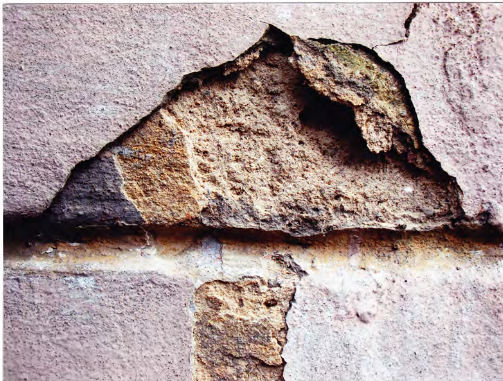
Fot. 15. Odkrywka nr 6 – bonie na prawej (zachodniej) krawędzi elewacji frontowej
