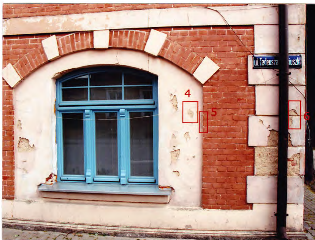
Fot. 11. Okno w skrajnej, prawej osi parteru. Widoczne odkrywki nr 4,5,6
