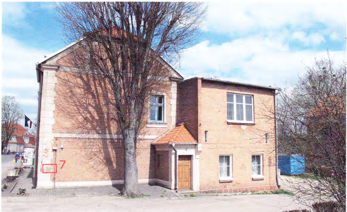
Ryc. 1, 2. Bisztynek, budynek przy ul. Kościuszki 2. Miejsce usytuowania odkrywek i pobrania próbek.
