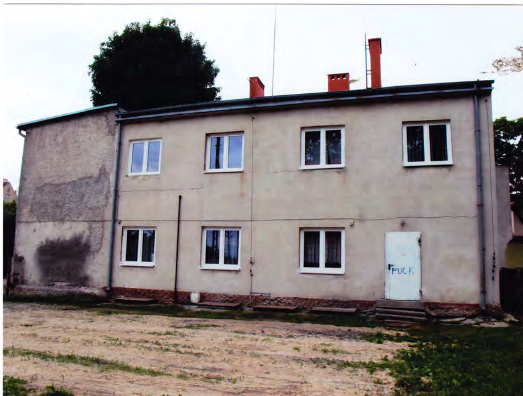
Fot. 4. Budynek przy ul. Kościuszki 2 w Bisztynku. Przybudówka od strony podwórza
