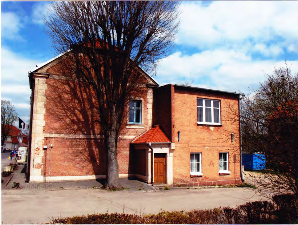
Fot. 3. Budynek przy ul. Kościuszki 2 w Bisztynku. Elewacja boczna południowo-zachodnia
