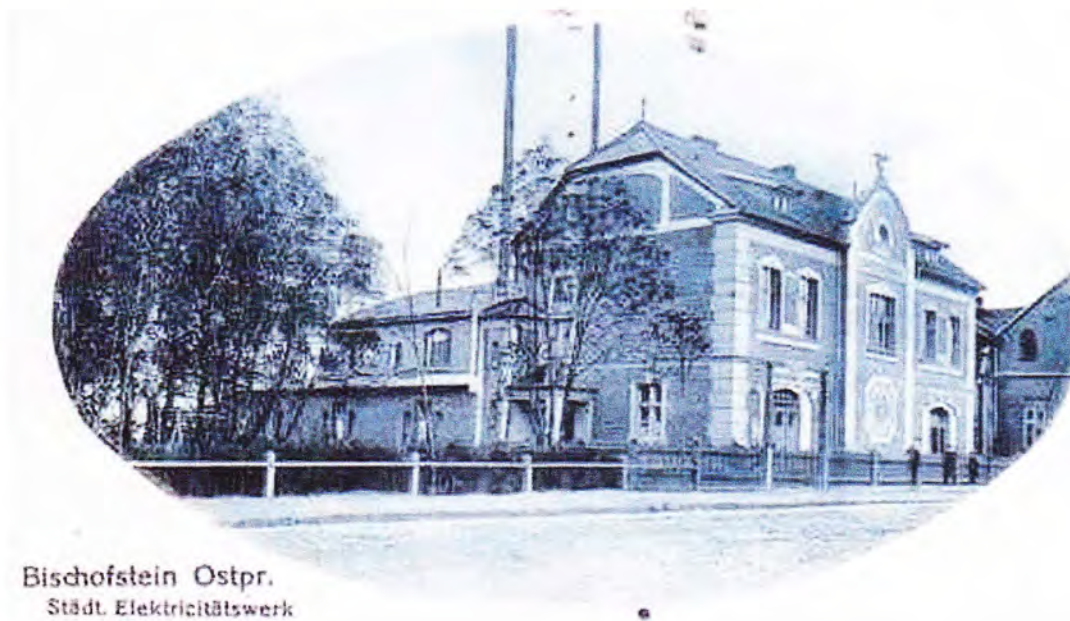
Ryc. 1. Budynek elektrowni miejskiej na początku XX w. Do elewacji podwórzowej przylegają zabudowania elektrowni. (źródło: http://www.bisztynek24.pl/fotografia.html )
