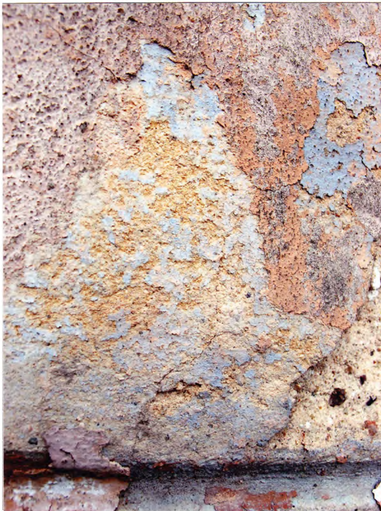
Fot. 19. Odkrywka nr 7 – widoczne jasnougrowe zabarwienie tynku, na nim kolejne warstwy
