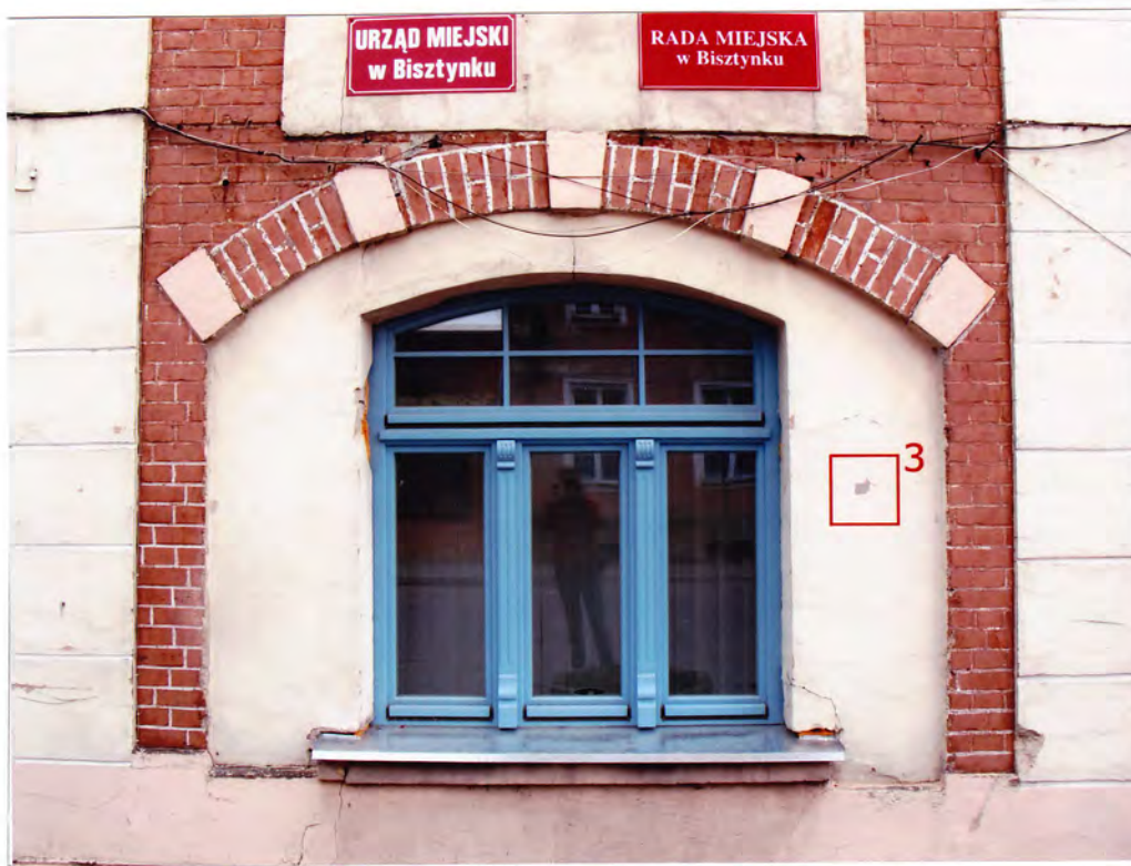
Fot. 9. Okno w środkowej osi na parterze elewacji frontowej. Pierwotnie w tym miejscu nie było otworu tylko tynkowana płycina, na której najprawdopodobniej umieszczony był herb miasta
