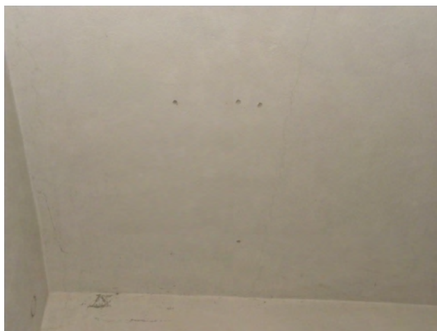
Fot.1. Nawiercony kanał w płycie stropowej
