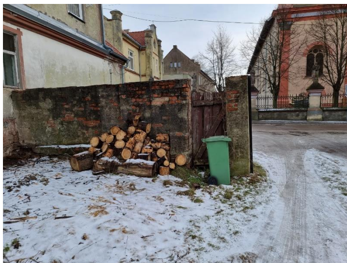
Obiekt nr 1 Mur ceglany
