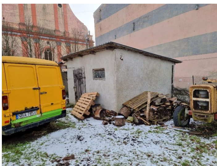
Obiekt nr 3 Budynek gospodarczy ceglany
