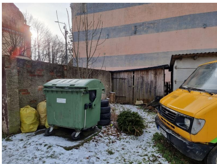
Obiekt nr 2 Budynek gospodarczy drewniany
