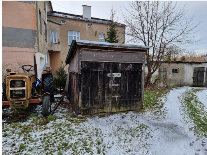
Obiekt nr 4 Budynek gospodarczy drewniany
