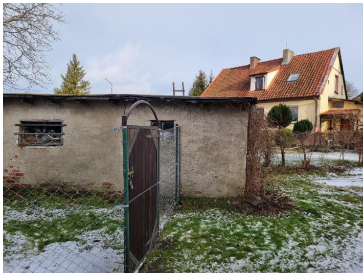
Obiekt nr 6 Budynek gospodarczy ceglany
