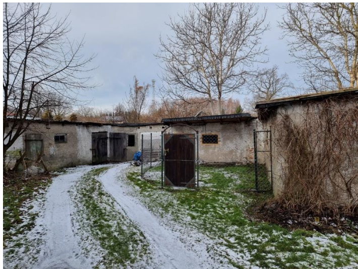
Obiekt nr 5 Budynek gospodarczy ceglany
