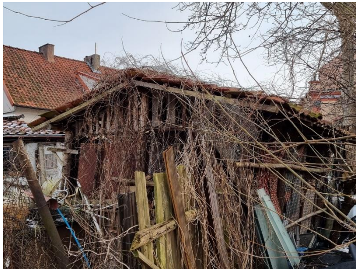
Obiekt nr 8 Wiata
