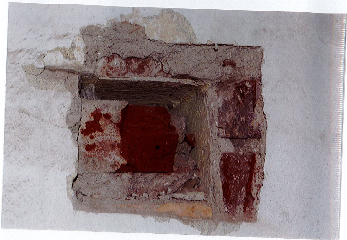
Fot. 4. Klatka schodowa. Odkrywka architektoniczna (J. Strużyński 2013) w miejscu dawnego przejścia do zachodniego pomieszczenia na piętrze (po lewej stronie otworu istniejącego współcześnie). Miejsce pobrania próbki nr 1 do analizy składu wyprawy.
