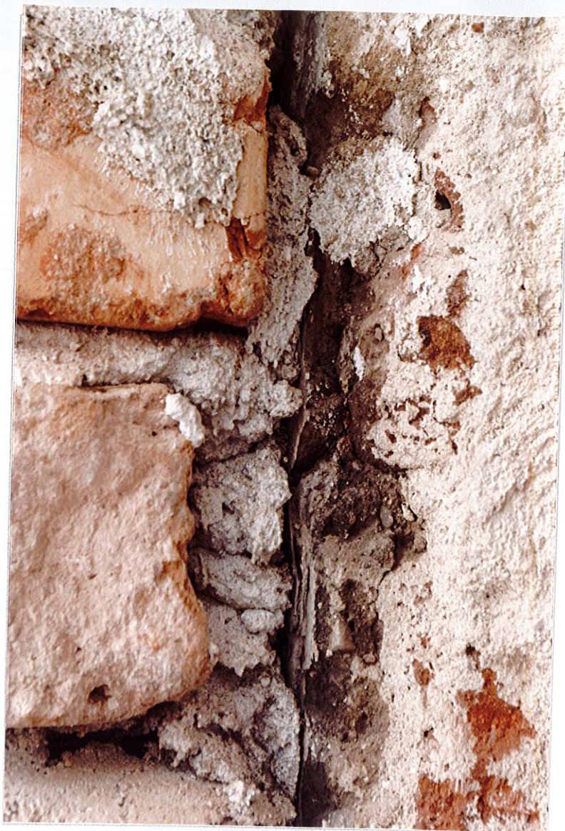
Fot. 11. Fragment dawnej wnęki okiennej na wschodniej ścianie wschodniego pomieszczenia na piętrze. Miejsce pobrania próbki nr 3 .
