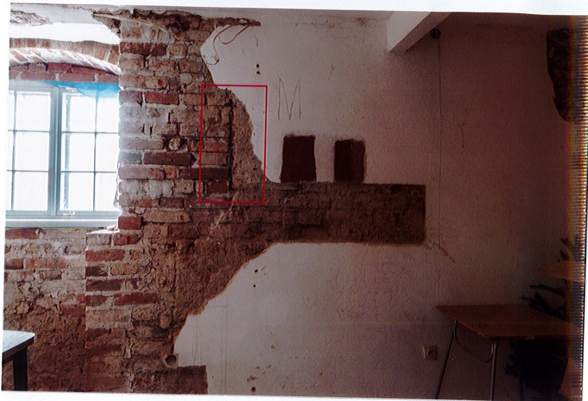
Fot. 10. Odkrywka architektoniczna we wschodnim pomieszczeniu na piętrze na ścianie wschodniej po prawej (południowej) stronie okna (J. Strużyński 2013). Podczas prac konserwatorskich elewacji w 2014 roku przemurowano otwory okienne, przywracając im XVIII-wieczną, barokową formę. Poszerzono powstałą w 2013 roku odkrywkę, odsłaniając krawędź dawnego (najprawdopodobniej gotyckiego) otworu okiennego z zachowanymi fragmentami tynku (miejscami zwęglonego), który pokrywają liczne pobiały wapienne. Miejsce zaznaczone czerwoną ramką, zbliżenie na fot nr. 11.
