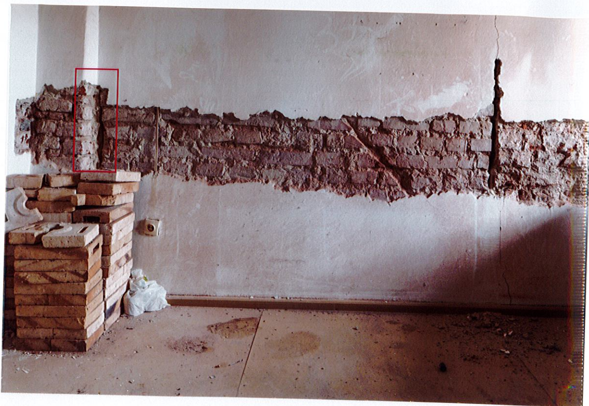
Fot. 7. Wschodnie pomieszczenie na piętrze, fragment odkrywki architektonicznej na ścianie północnej (J. Strużyński, 2013). Widoczne różne rodzaje murów wzajemnie nie przewiązanych, między widocznymi szwami mur nowożytny, po obu stronach mury gotyckie. Czerwoną ramką zaznaczony dawny filar szerokiego otworu drzwiowego z pokrywającym jego lico tynkiem.
