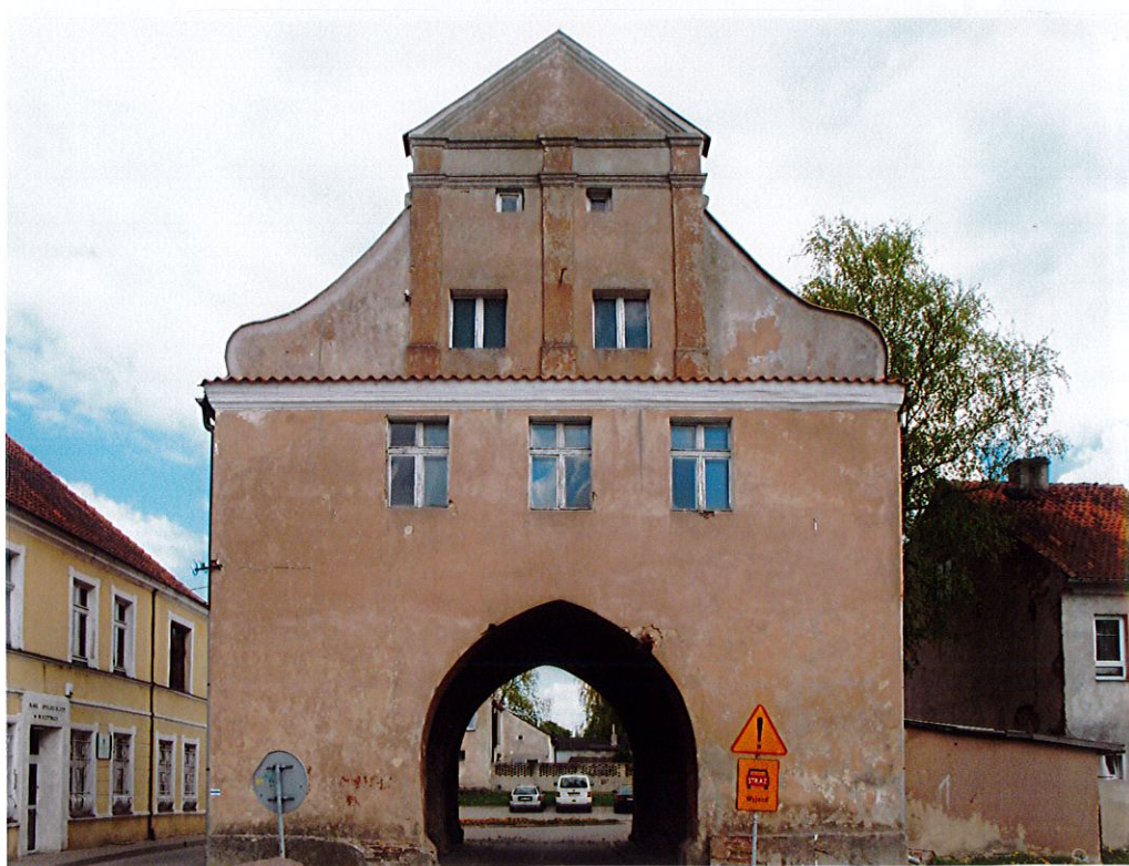
XV. Brama Lidzbarska w roku 2013. Widok na elewację północno-zachodnią.
