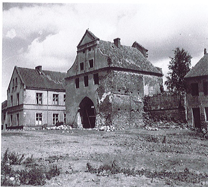
IX-X. Brama lidzbarska przed rozpoczęciem prac konserwatorskich. Na tzw. zielonej karcie pod zdjęciami umieszczono datę 8 VI 1958 r. (źródło: WUOZ Olsztyn)
