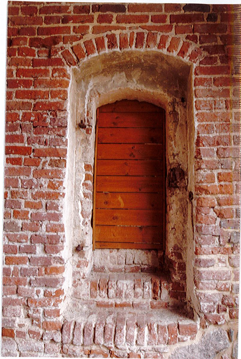
Fot. 13. Przejście z przejazdu bramnego do klatki schodowej, zamurwane najprawdopodobniej w XIX w., odkryte i udrożnione podczas prac konserwatorskich w 2014 roku.
