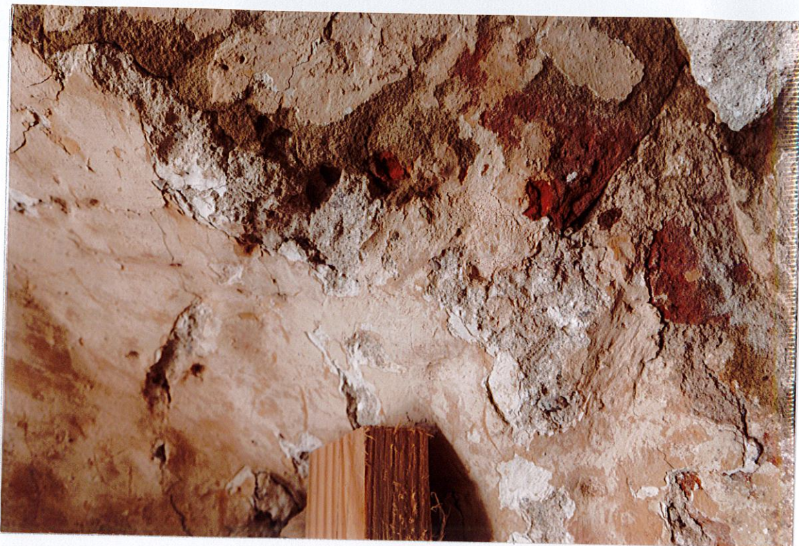
Fot. 14. Wnęka przejścia z przejazdu bramnego, fragment od strony wnętrza klatki schodowej. Na podłuczcu widoczny jasny tynk, na ścianie – tynk o zabarwieniu ciemnobeżowym. Na obu ugrów warstwa malarska.
