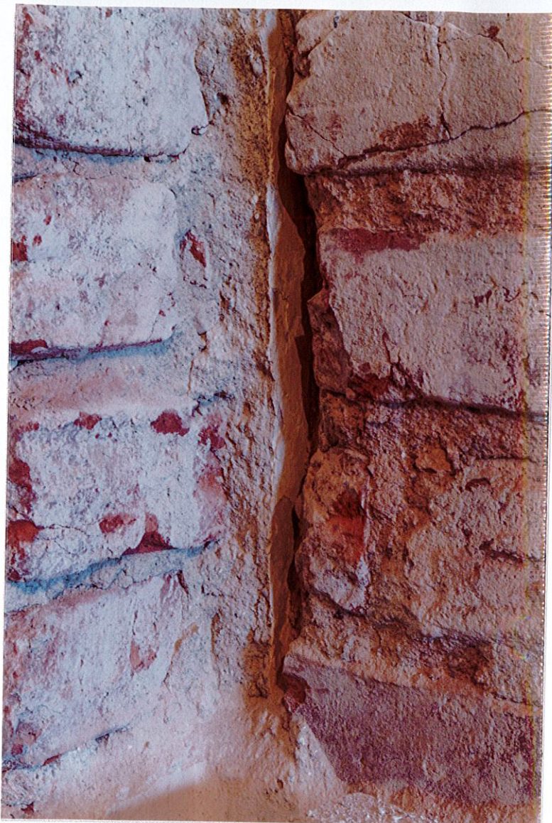
Fot. 8. Wschodnie pomieszczenie na piętrze, fragment odkrywki architektonicznej na ścianie północnej (J. Strużyński, 2013), zaznaczony czerwoną ramką na fot. nr 7. Na filarze zamurowanego przejścia na klatkę schodową widoczny zachowany tynk, który najprawdopodobniej w przeszłości pokrywał ścianę oraz leżące na nim pobiałe.
