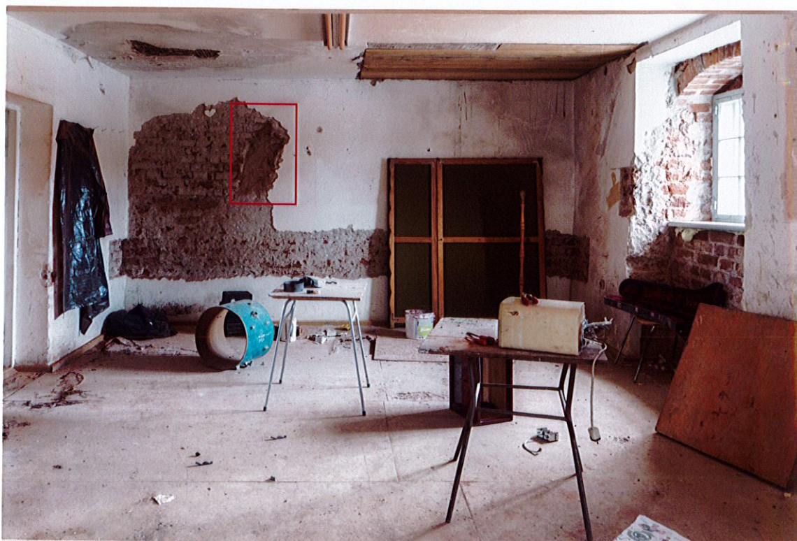
Fot. 17. Pomieszczenie zachodnie na piętrze, ściana południowa. W odkrywce architektonicznej (J. Strużyński 2013) widoczna wnęka pokryta tynkiem (zaznaczona czerwoną ramką). Miejsce pobrania próbki nr 5.
