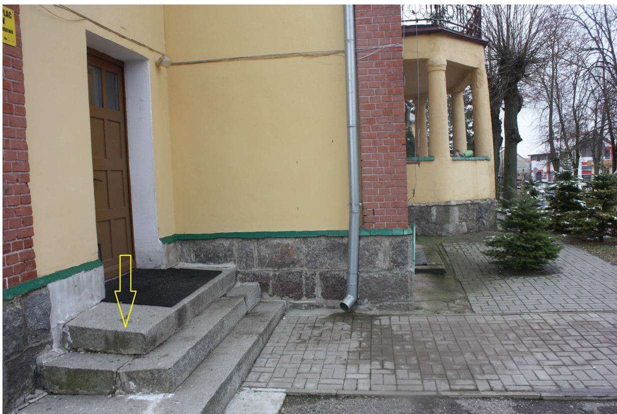
Zdjęcie nr 10 – Schody zewnętrzne na pater od strony południowej
