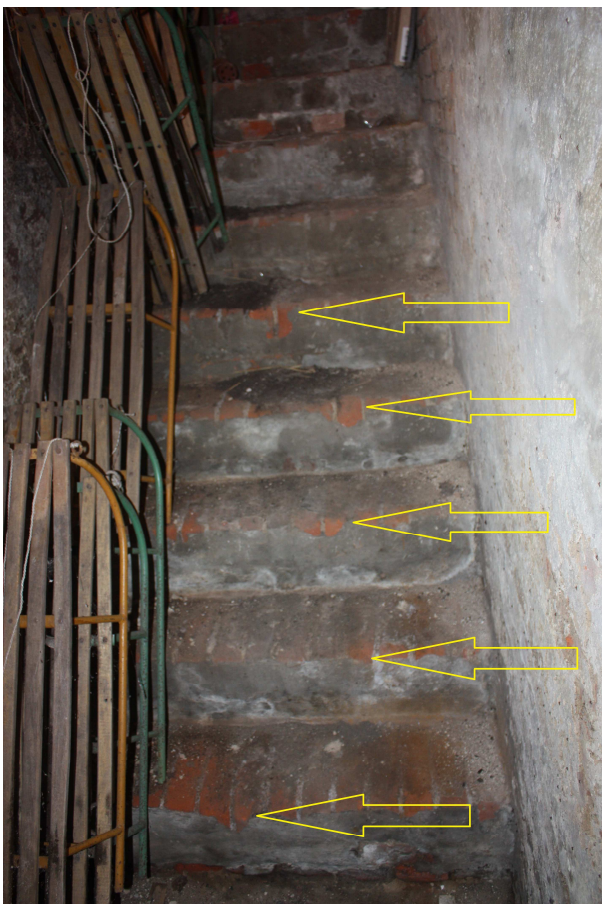
Zdjęcie nr 06 – Schody do piwnicy w części B
