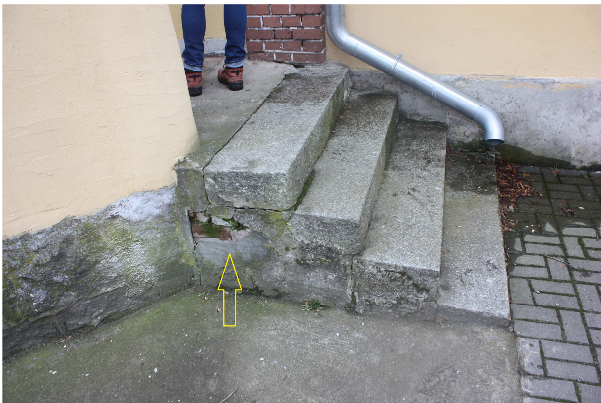
Zdjęcie nr 11 – Schody zewnętrzne na pater od strony południowej (wejście pod tarasem)
