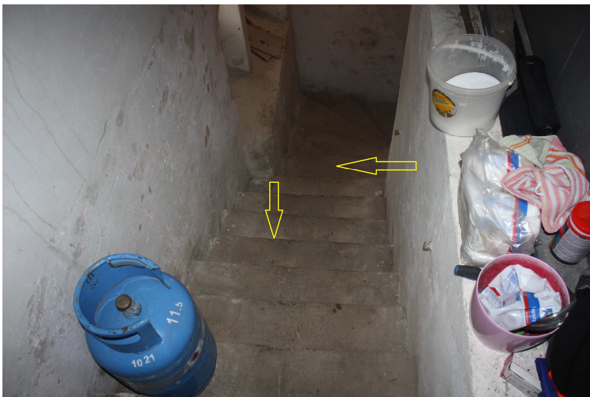
Zdjęcie nr 05 – Schody do piwnicy w części A
