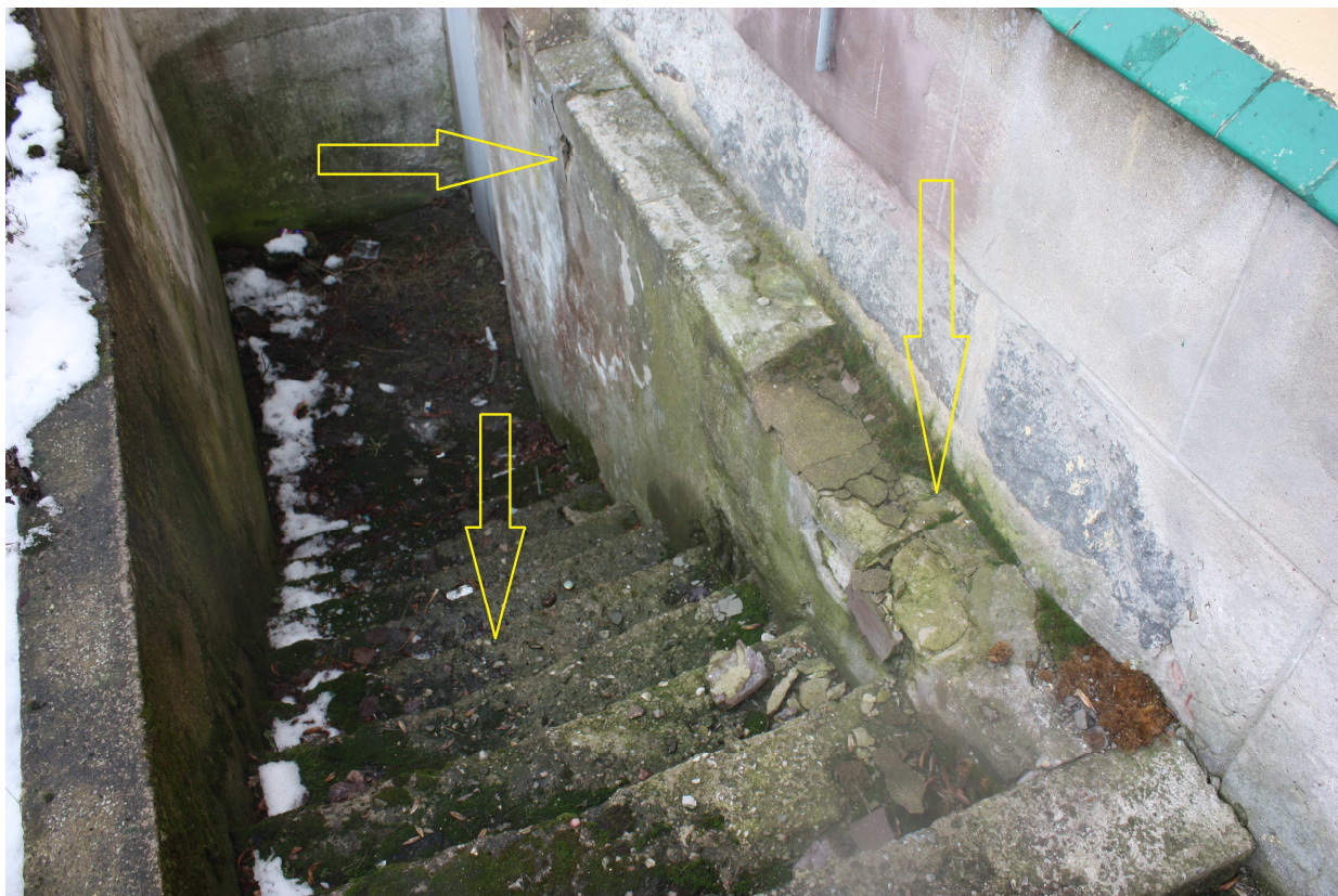
Zdjęcie nr 09 – Schody zewnętrzne do piwnicy od strony północnej
