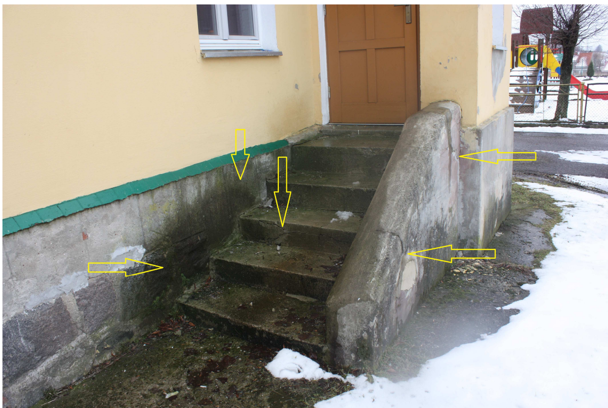
Zdjęcie nr 08 – Schody zewnętrzne na parter od strony północnej
