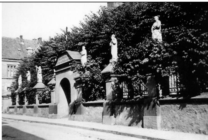
Bisztynek, ogrodzenie kościoła katolickiego, 1938 r.
