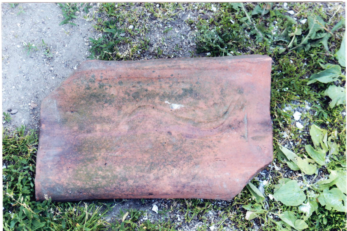
Fot. 27. Dachówka, najprawdopodobniej z dawnego pokrycia, zmienionego po zniszczeniach spowodowanych gradobiciem z 2012 roku.
