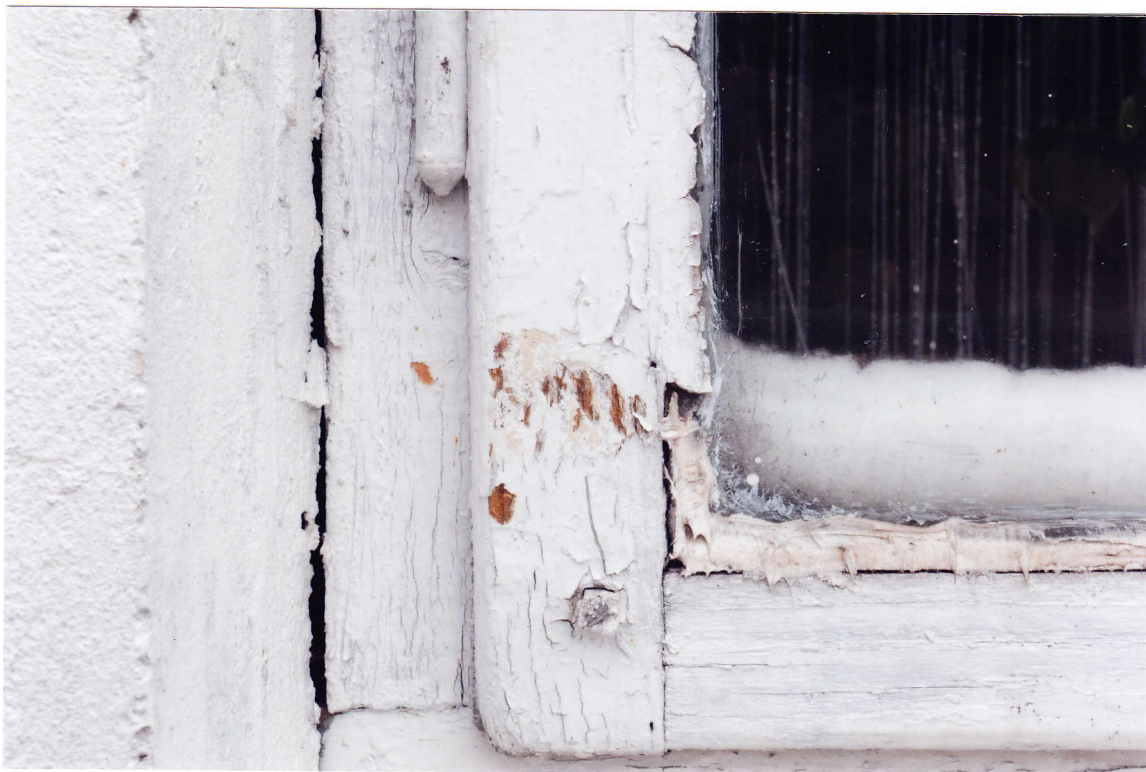
Fot. 25. Odkrywka nr D3. Na oknie widoczne są tylko białe warstwy malarskie.
