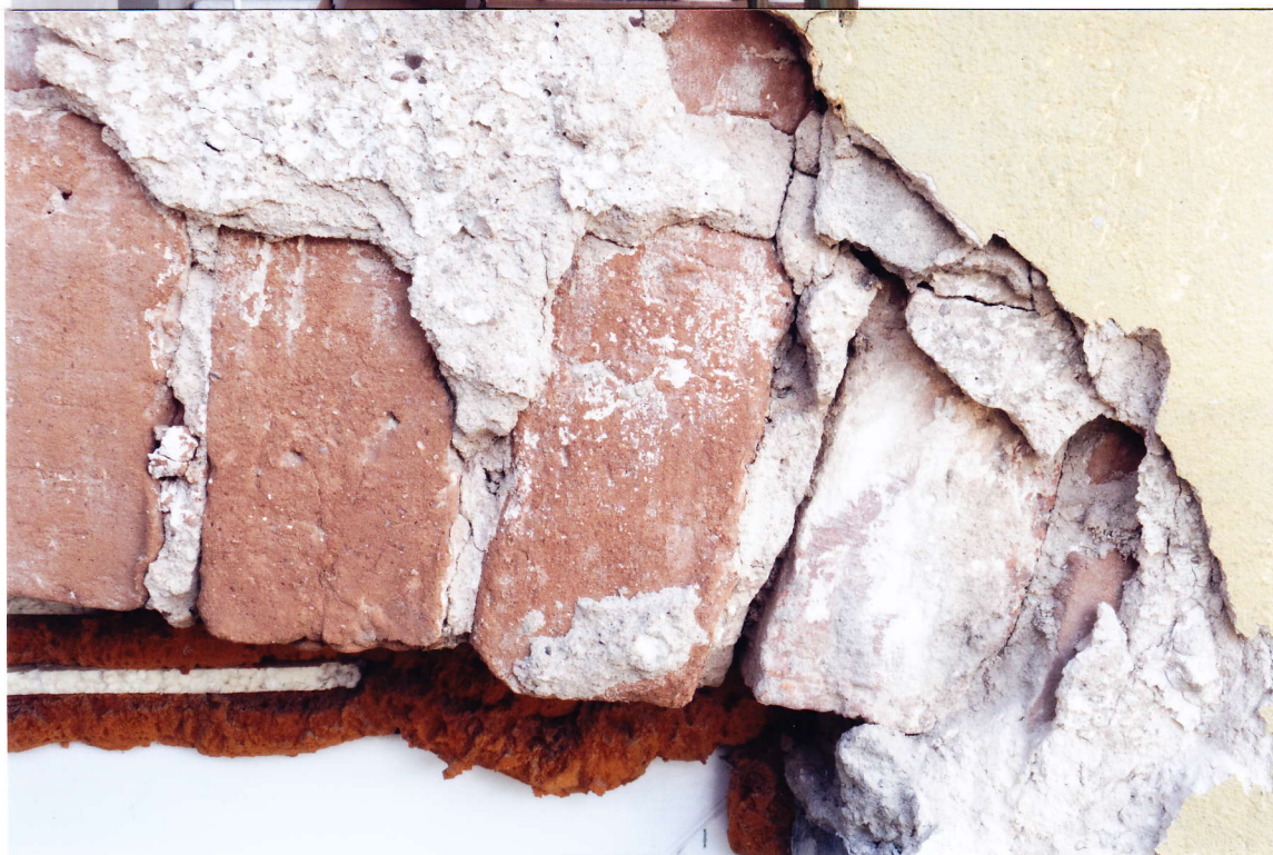
Fot. 22. Odkrywka nr 5 , fragment – pod tynkiem, który obecnie widoczny jest na całej elewacji zachował się tynk wapienny z warstwą pobiała – zapewne ten tyk widoczny jest na lotniczym zdjęciu wykonanym między 1930 a 1939 rokiem (ryc. 1). Pobiała leży również na ceglach, być może jest to ślad po doraźnych naprawach – ściany pobielono bez uzupełniania ubytków tynku.
