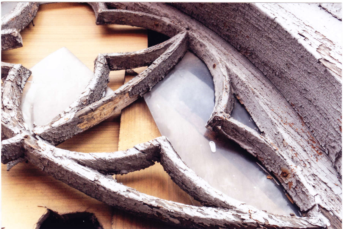
Fot. 17. Odkrywka nr D1 na zachowanym maswerkowym okienku.
