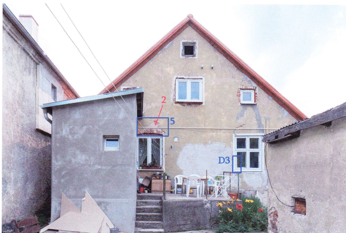
Ryc. 2,3. Bisztynek, budynek przy ul. Kościuszki 2. Miejsce usytuowania odkrywek i pobrania próbek.
