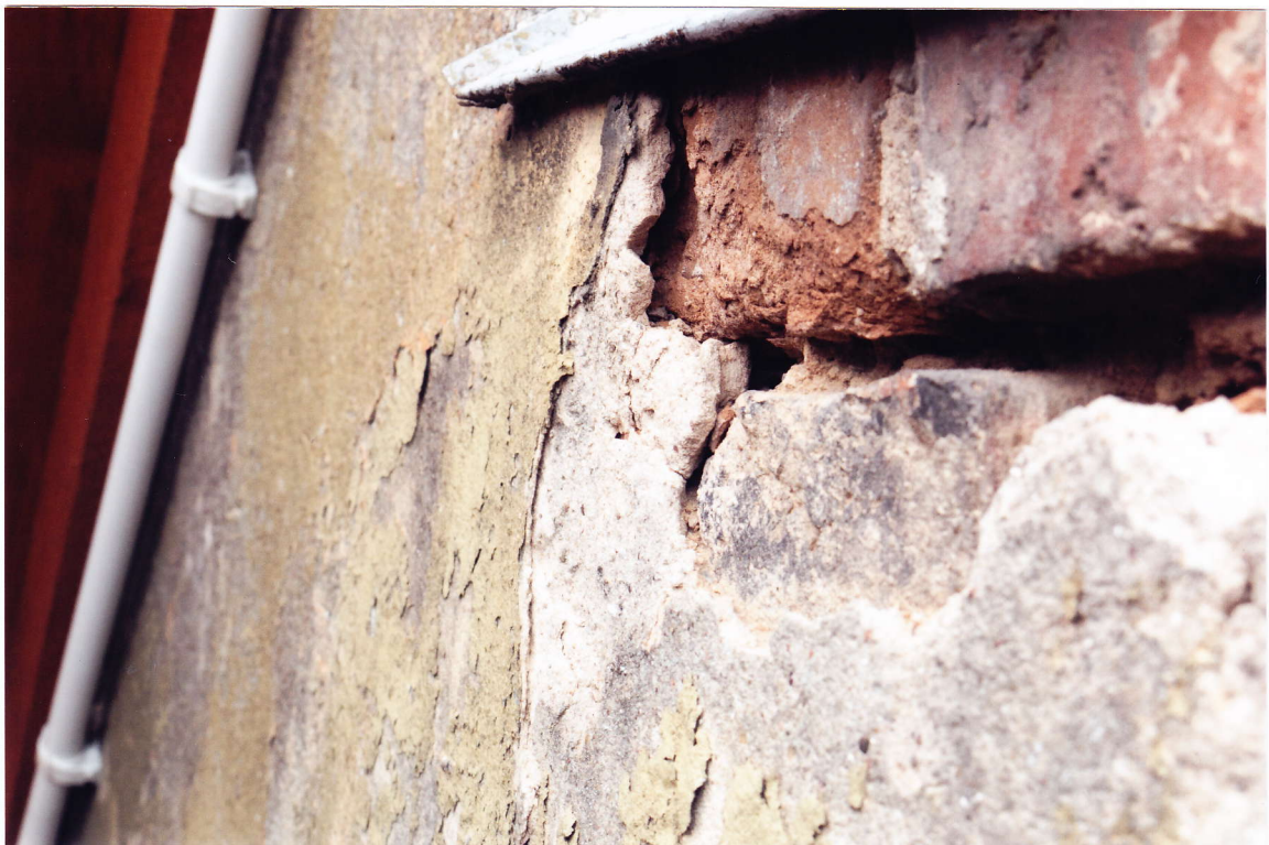
Fot. 14. Odkrywka nr 4 poniżej półokrągłego okienka w elewacji zachodniej.
