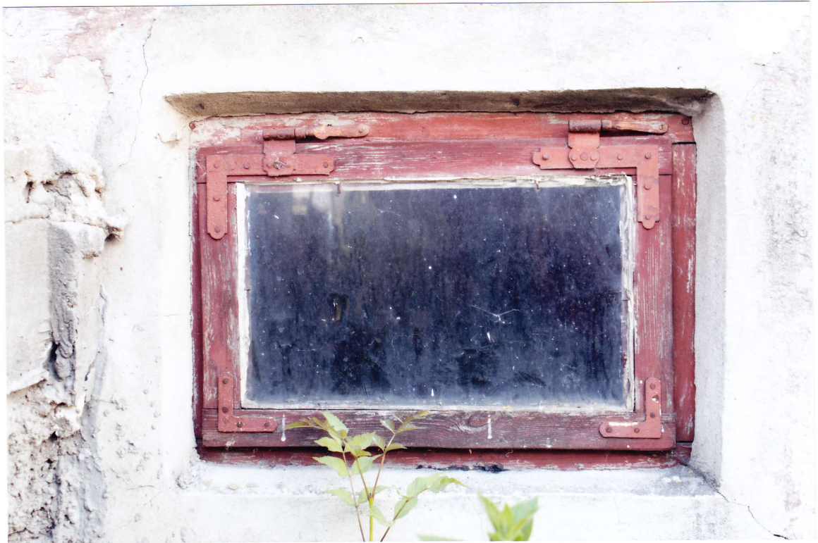
Fot. 26. Okno piwniczne w elewacji wschodniej pomalowano wtórnie wraz z zawiasami na kolor brunatnoczerwony.
