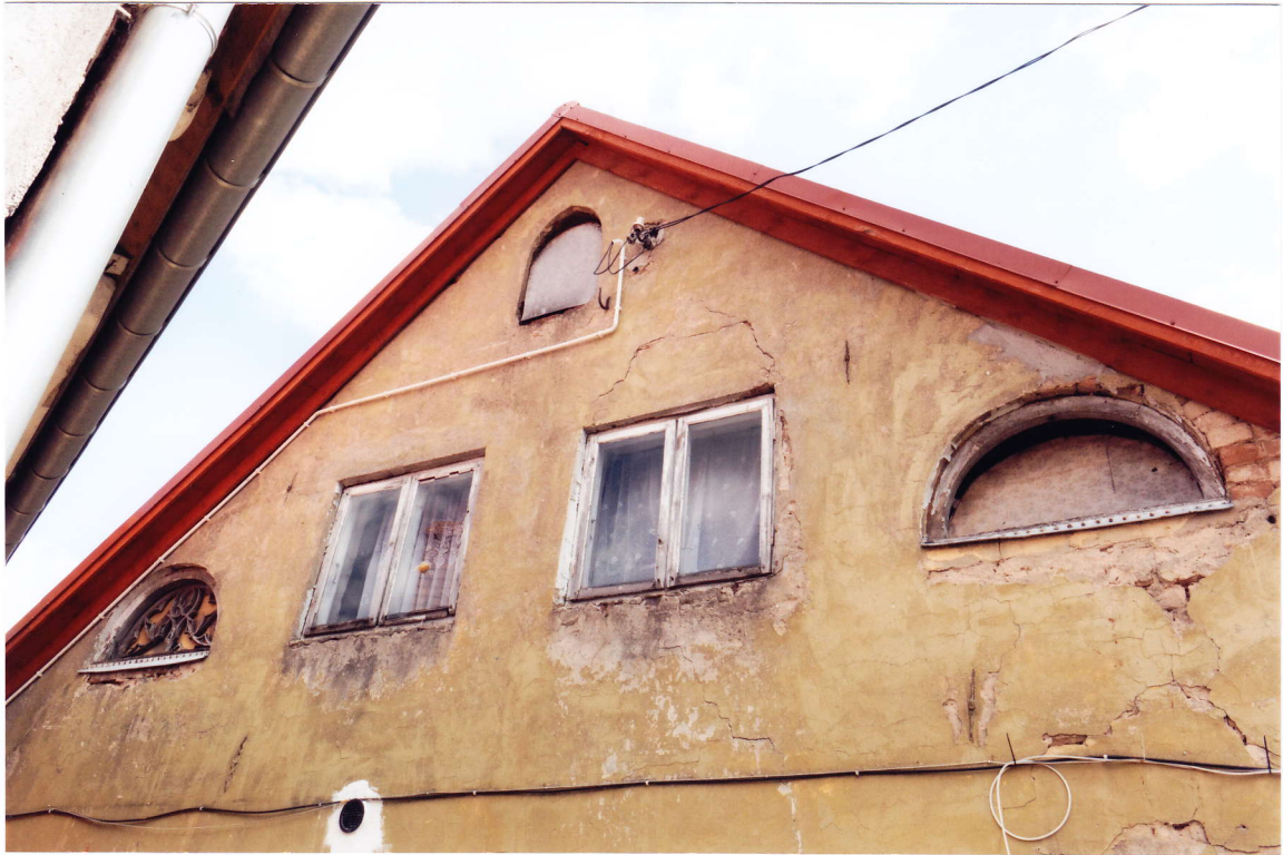
Fot.16. Elewacja zachodnia – górne kondygnacje (poddasze). W tej elewacji zachowały się dwa półokrągłe okienka, najprawdopodobniej z najstarszej pierwotnej redakcji elewacji budynku. Nie można wykluczyć, że także prostokątne obecnie okna na piętrze miały inną formę zamknięcia od góry (np. łuk odcinkowy). Widoczne są spękania, które mogą być spowodowane przeróbkami w obrębie nadproży. Podczas prac konserwatorskich usunięte zostaną wszystkie widoczne na elewacji, wtórne tynki, będzie więc można dokładnie ocenić pierwotną formę otworów. Maswerkowe okna są najciekawszym zachowanym elementem budynku.
