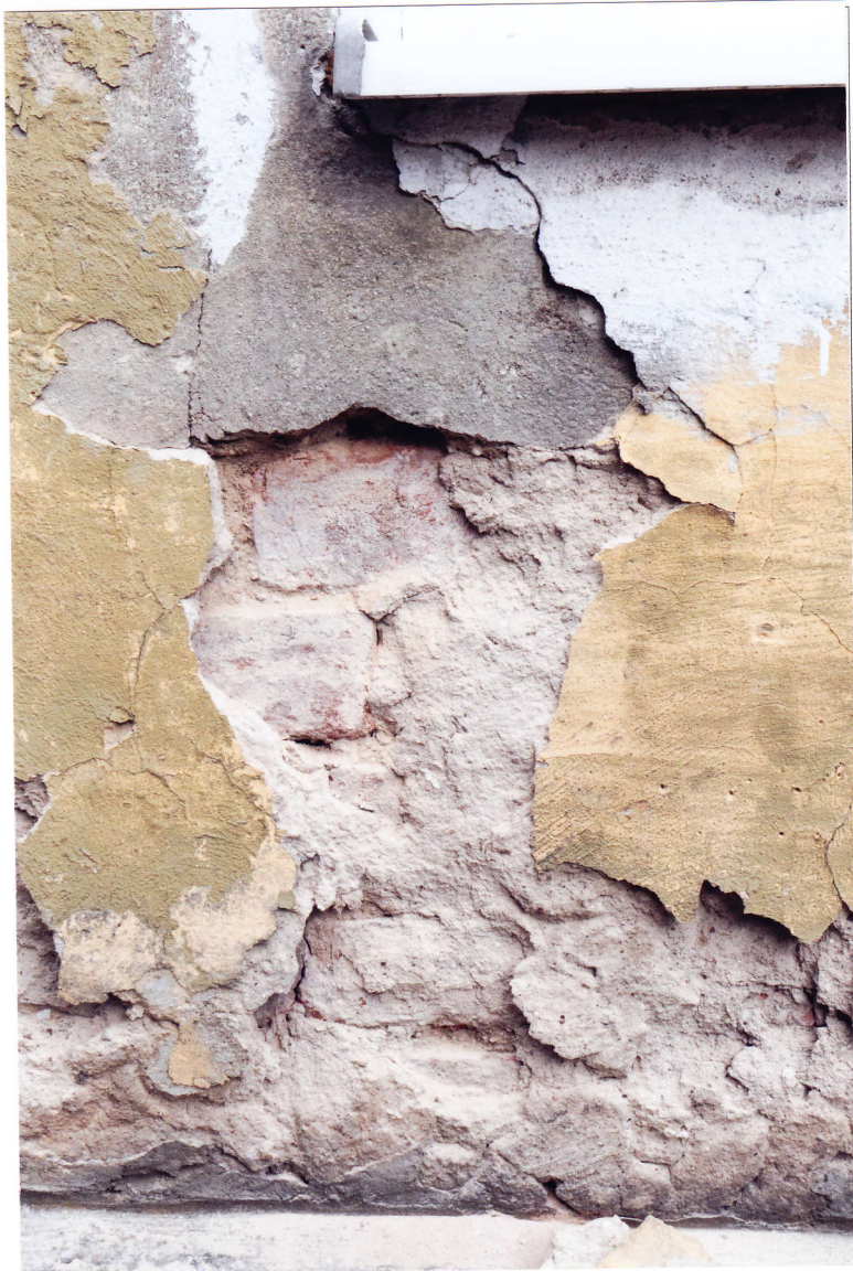
Fot. 12. Odkrywa nr 3 pod oknem parteru w elewacji zachodniej. Pod najmłodszymi chronologicznie nawarstwieniami widoczny twardy, cementowy tynk, który otacza otwór okienny. Można przypuszczać, jest to tynk z czasów remontu, podczas którego zmieniono kształt lub rozmiar okien – najprawdopodobniej wszystkie otwory okienne na parterze miały formę prostokątów zamkniętych od góry łukiem odcinkowym.
