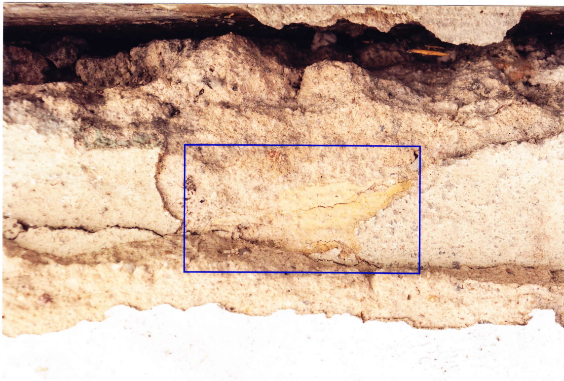
Fot. 7. Fragment odkrywki nr 1 , pod wtórnymi nawarstwieniami widoczne relikty najstarszych opracowań barwnych w kolorze żółtym (w ramce).
