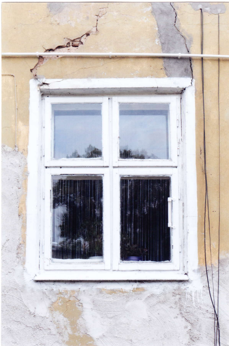
Fot. 24. Okno o konstrukcji polskiej w elewacji wschodniej najprawdopodobniej zastąpiło wcześniejsze, dopasowane do otworu zamkniętego od góry łukiem odcinkowym.
