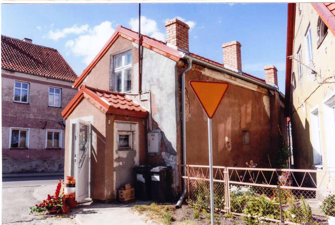
Fot. 4. Budynek przy ul. Sienkiewicza 3 w Bisztynku. Widok od południa na elewację południowo-zachodnią z dobudowanym wiatrołapem.
