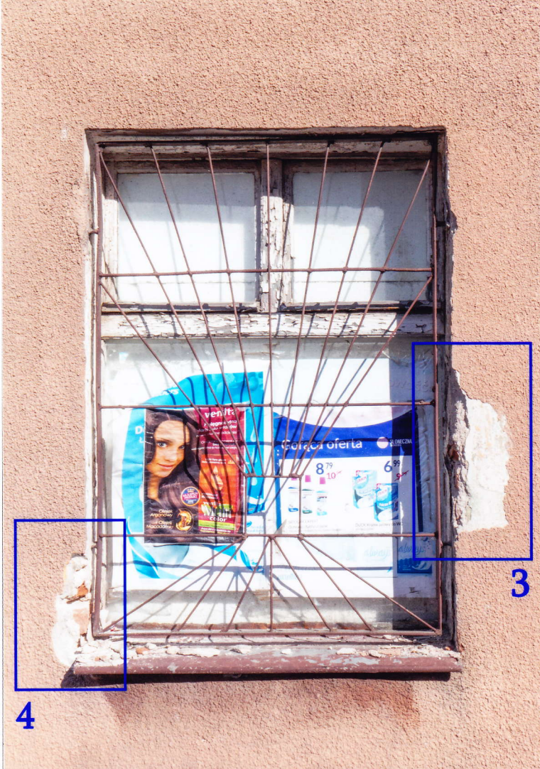
Fot. 11. Okno w elewacji północno-zachodniej (drugie od północy). Widoczne odkrywki.
