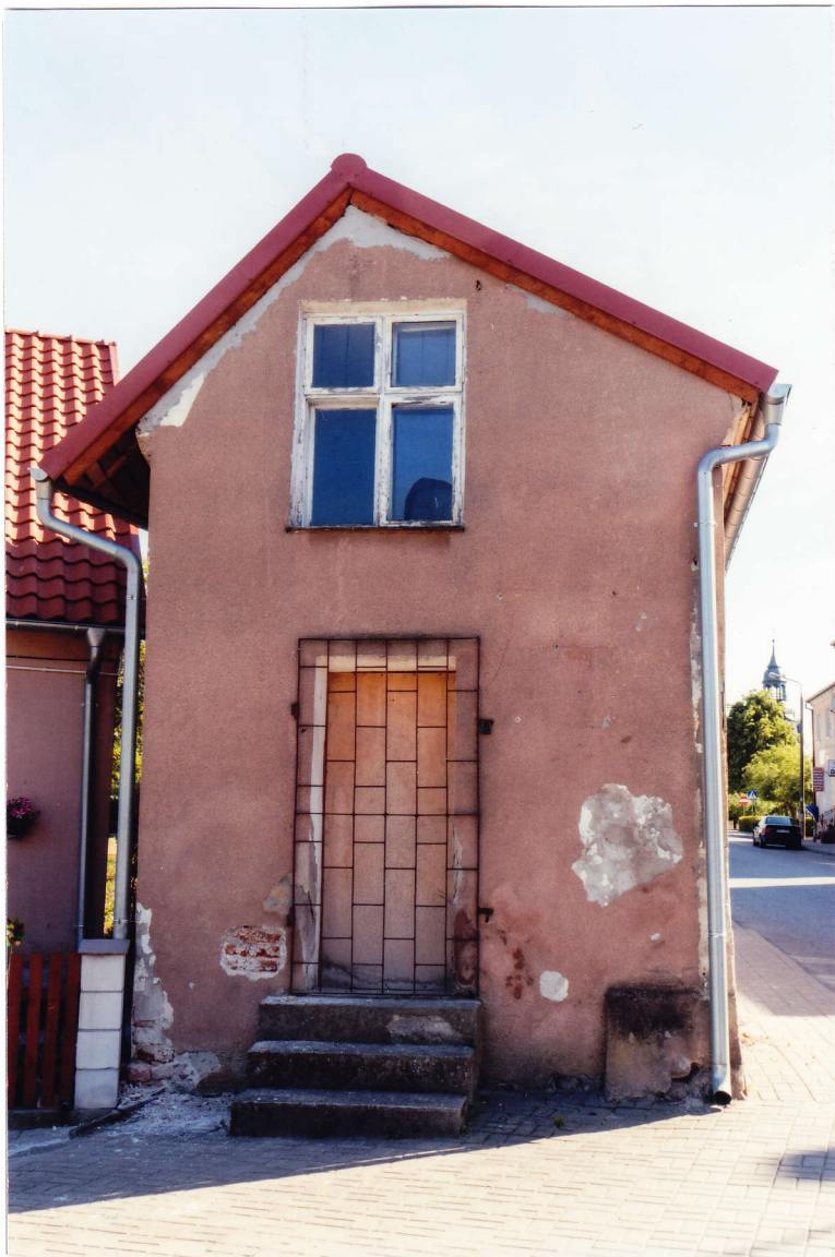
Fot. 3. Budynek przy ul. Sienkiewicza 3 w Bisztynku. Elewacja boczna północno-wschodnia z nieużywanym wejściem. Okna doświetlające poddasze są odmiennie od tych, które zachowały się w dwóch otworach na parterze (ościeżnicowe, pobawione dekoracji snycerskich). Być może pierwotnie poddasze doświetlały, mniejsze okienka, jednak na zdjęciu lotniczym z lat 30. XX w. można zauważyć prostokątne zaciemnienie w szczycie, co mogłoby wskazywać na obecność okna o zachowanej obecnie wielkości (ryc. 1).
