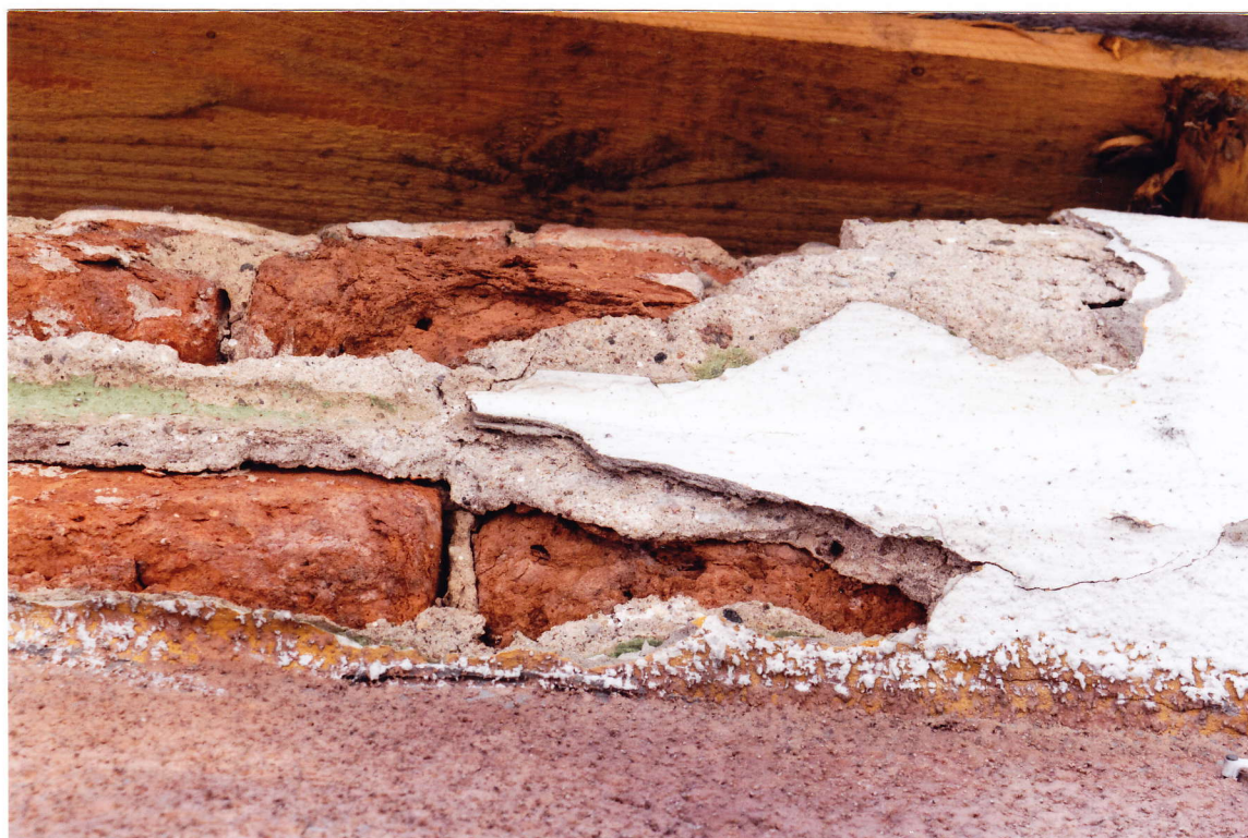
Fot. 19. Odkrywka nr 8 – gzyms w elewacji podwórzowej.
