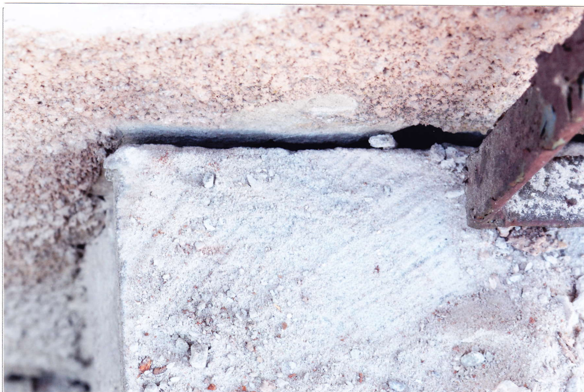
Fot. 27. Schody w elewacji północno-wschodniej dobudowano wtórnie, być może podczas wybijania otworu drzwi wejściowych.
