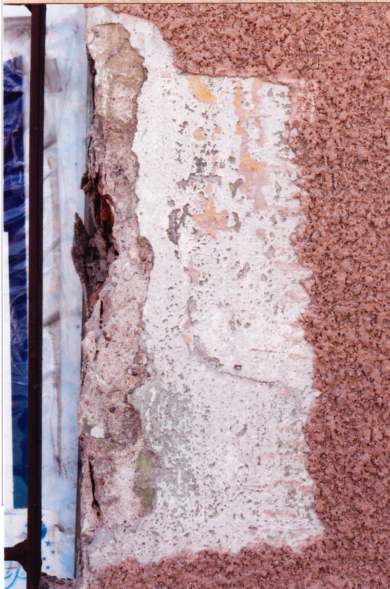
Fot. 12. Odkrywka nr 3.
