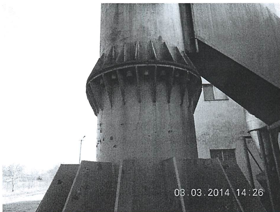
Fot.2 Część pod czopuchem komina wraz z połączeniem kołnierzym i oparciem komina na stopie fundamentowej
