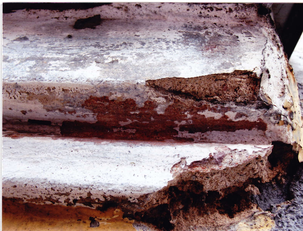
Fot. 32. Odkrywka nr 13 na gzymsie parapetowym na parterze
