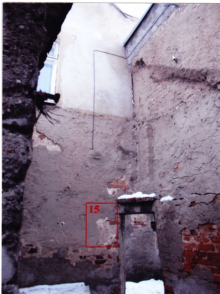
Fot. 34. Odkrywka nr 15 , ściana południowo-wschodnia, przylegająca do podwórka oddzielającego kamieniczkę od zabudowy sąsiedniej działki
