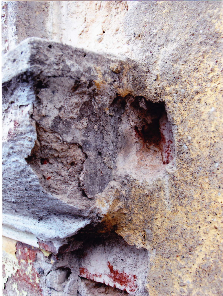
Fot. 30. Odkrywka nr 10 na gzymsie parapetowym okna poddasza
