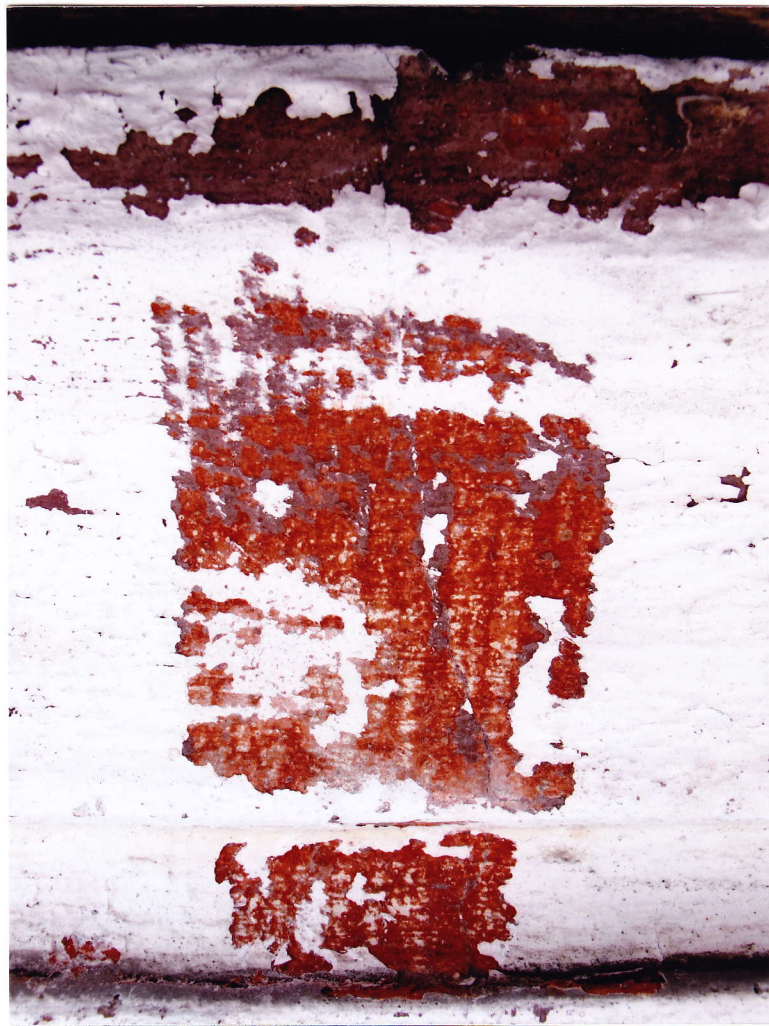
Fot. 25. Odkrywka nr 5 na górnym profilu gzymsu podokapowego
