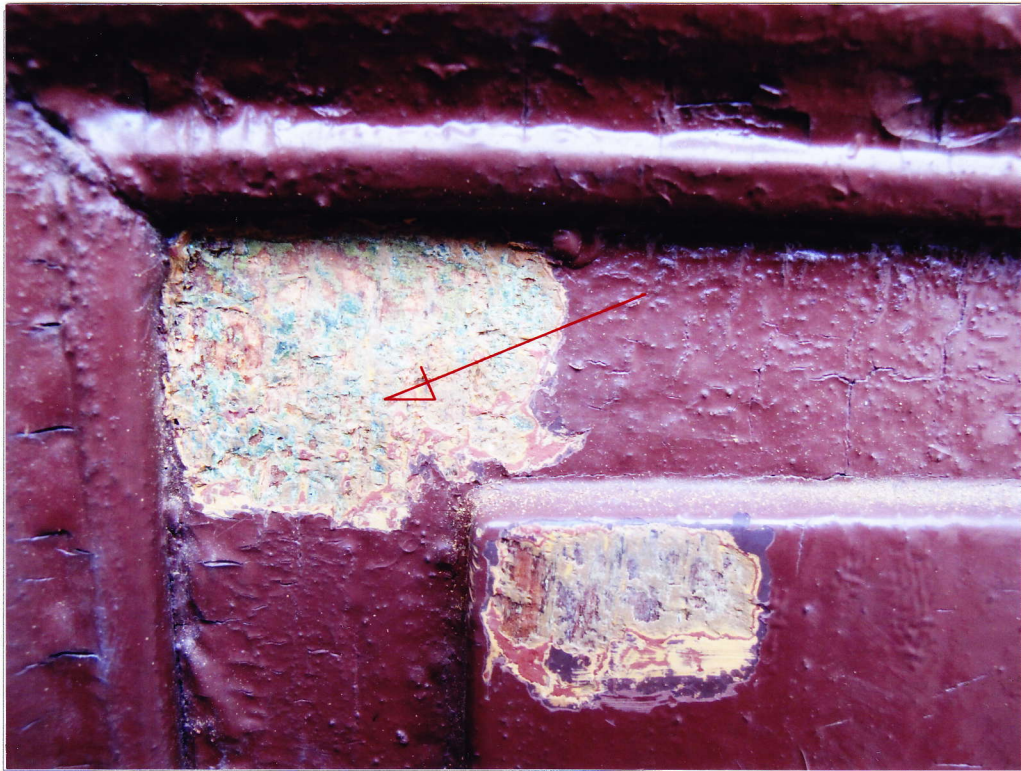
Fot. 38. Awers drzwi wejściowych, odkrywki nr D2 i D3
