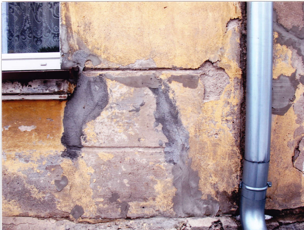
Fot. 5. Elewacja frontowa, parter. Przy prawej krawędzi zachowały się fragmenty pierwotnego boniowania.
