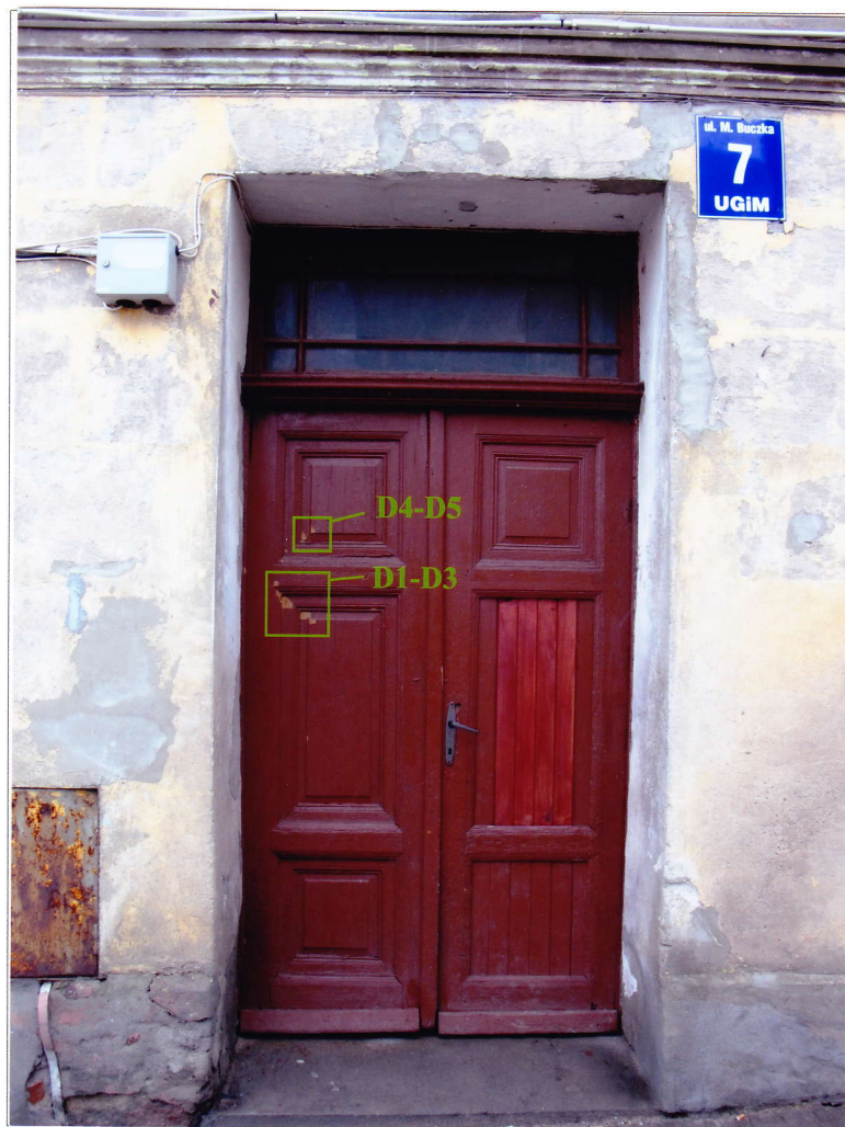
Fot. 37. Drzwi wejściowe, awers. Widoczna lokalizacja odkrywek
