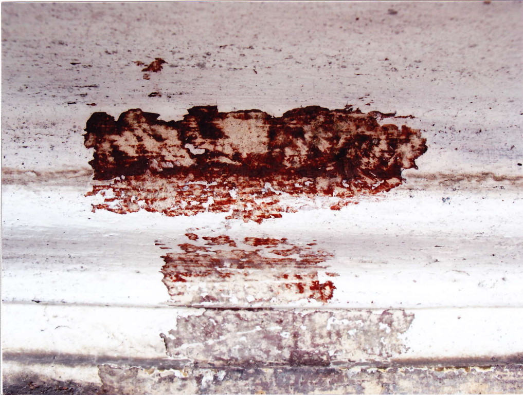
Fot. 23. Odkrywka nr 6 na dolnym profilu gzymsu podokapowego
