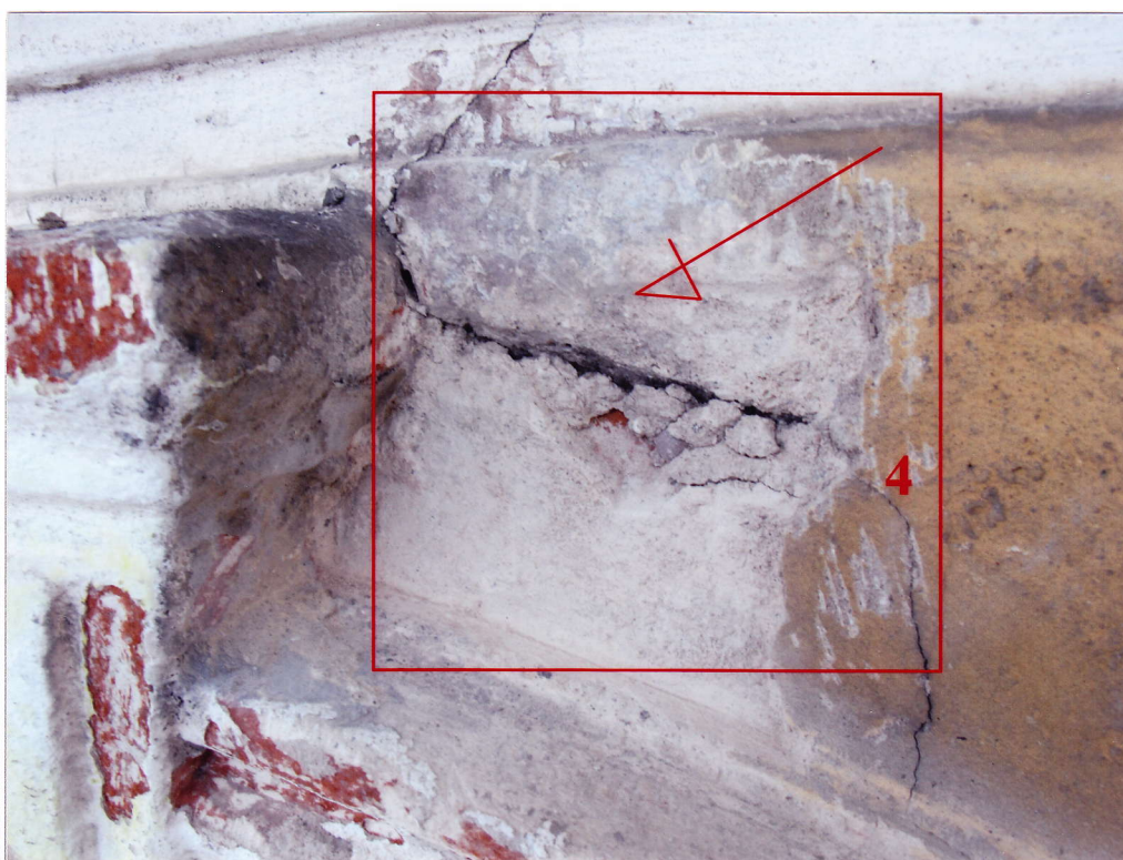
Fot. 17. Fragment gzymsu koronującego oraz opaski okna poddasza z zaznaczoną lokalizacją odkrywek
