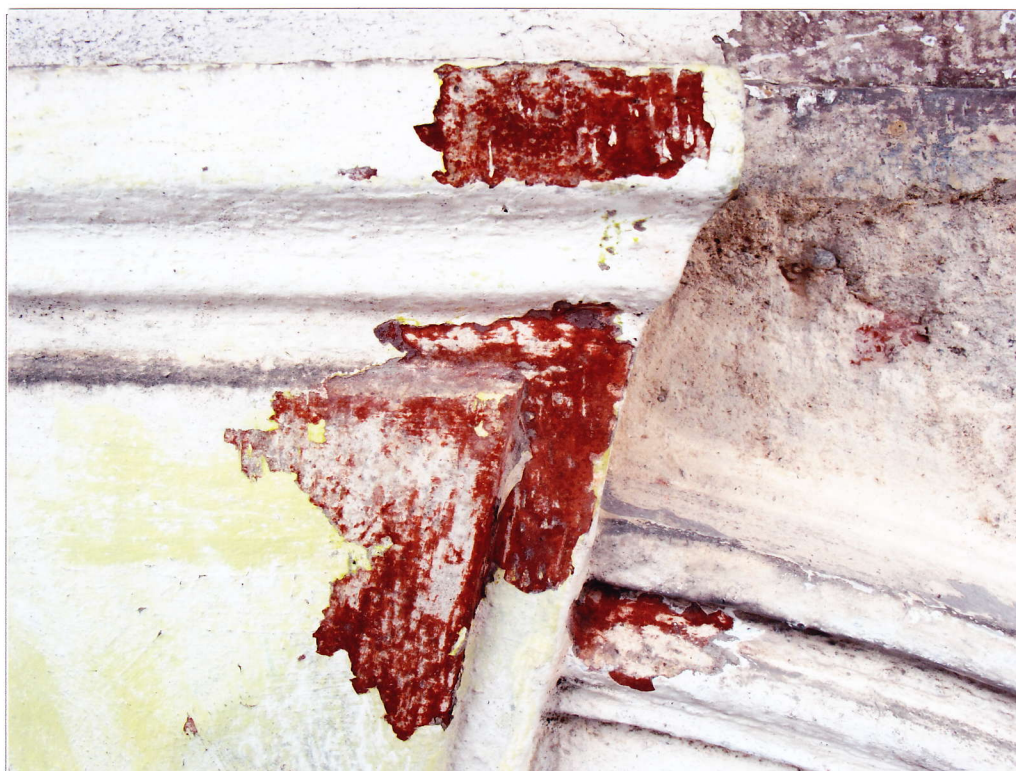
Fot. 27. Odkrywka nr 7 – opaska okna poddasza
