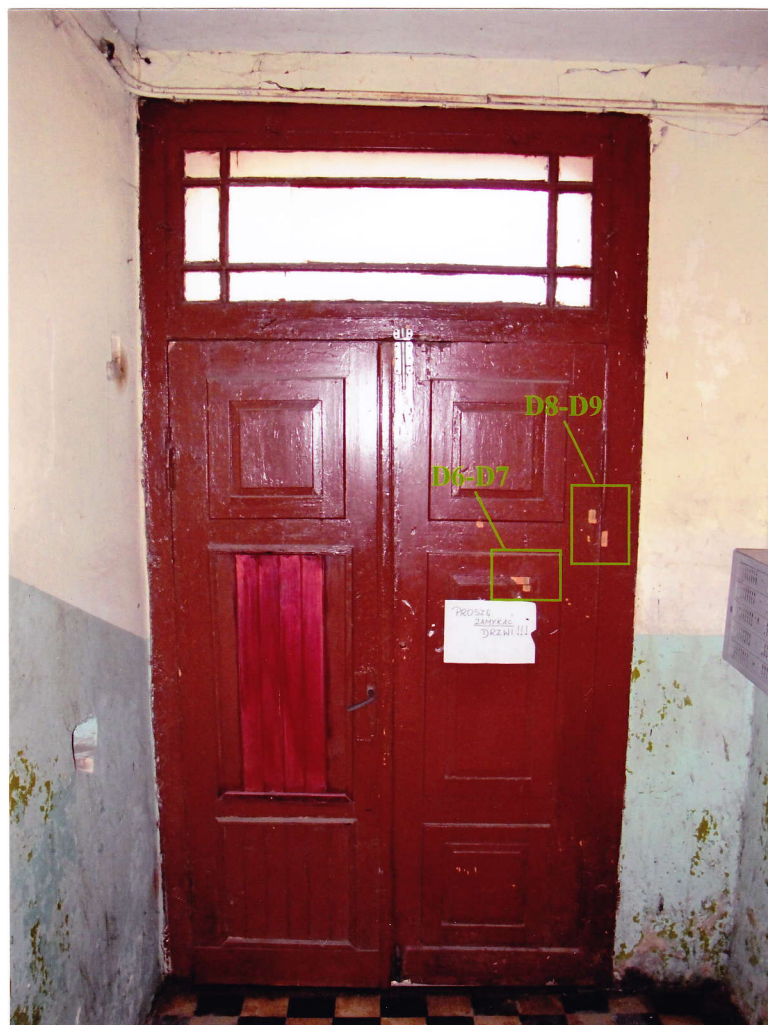
Fot. 42. Drzwi wejściowe – rewers. Na zdjęciu widoczna lokalizacja odkrywek
