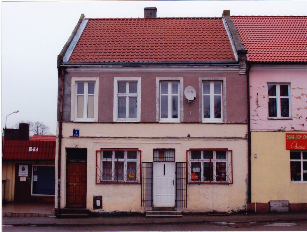
Fot. 1. Elewacja frontowa
