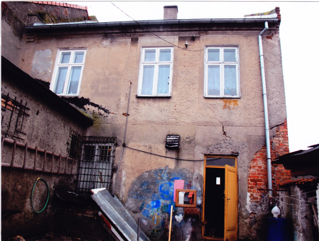
Fot. 2. Elewacja podwórzowa
