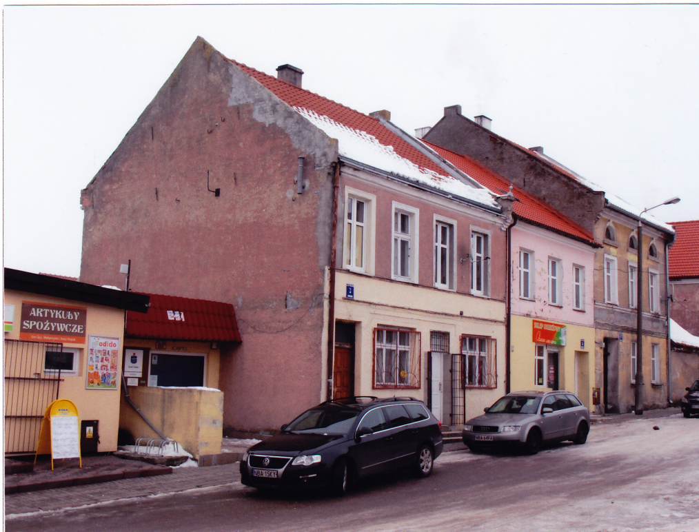
Fot. 3. Ściana szczytowa (północno-zachodnia)
