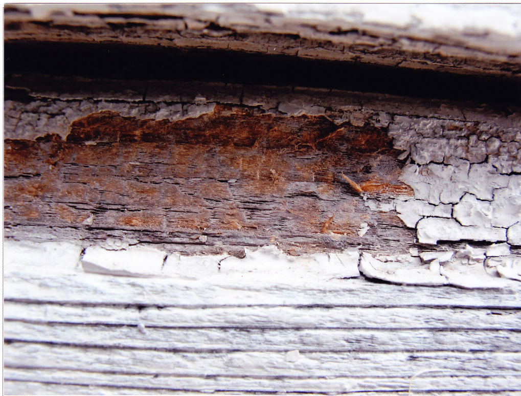
Fot. 20. Odkrywka nr D1 na ślimieniu okna na pierwszym piętrze
