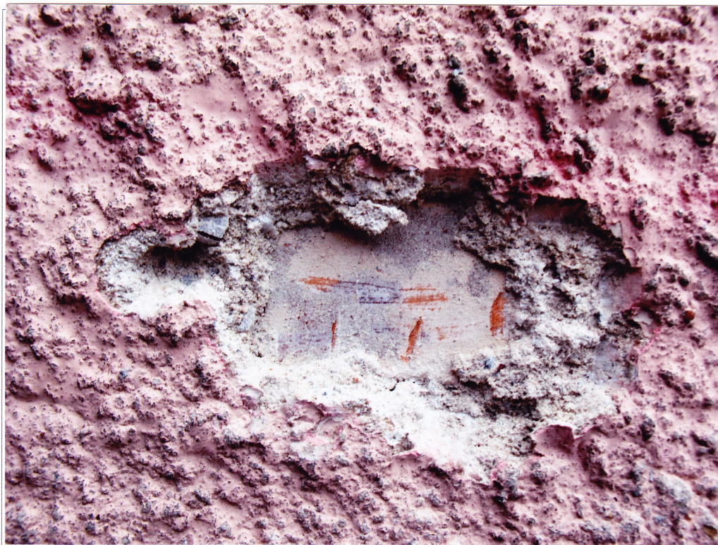
Fot. 19. Odkrywka nr 13 na północno-zachodniej ścianie szczytowej kamienicy. Najprawdopodobniej podczas remontu związanego ze wzmocnieniem tej ściany na elewację boczną i frontową położono fakturalny tynk z warstwą wymalowania kolorze różowym
