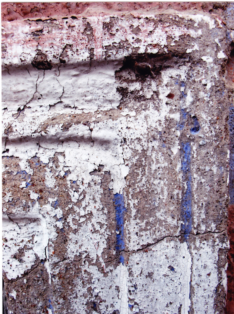
Fot. 16. Odkrywka nr 5 – profilowana opaska okna na 1. piętrze. Pod warstwą białej malatury zachowały się relikty warstwy malarskiej w kolorze niebieskim
