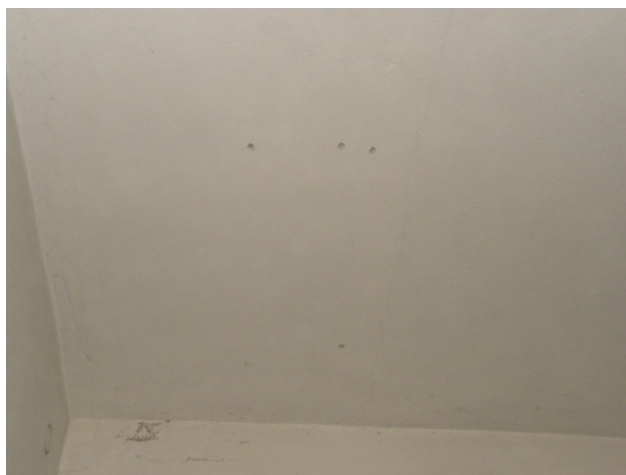
Fot.1. Nawiercony kanał w płycie stropowej
